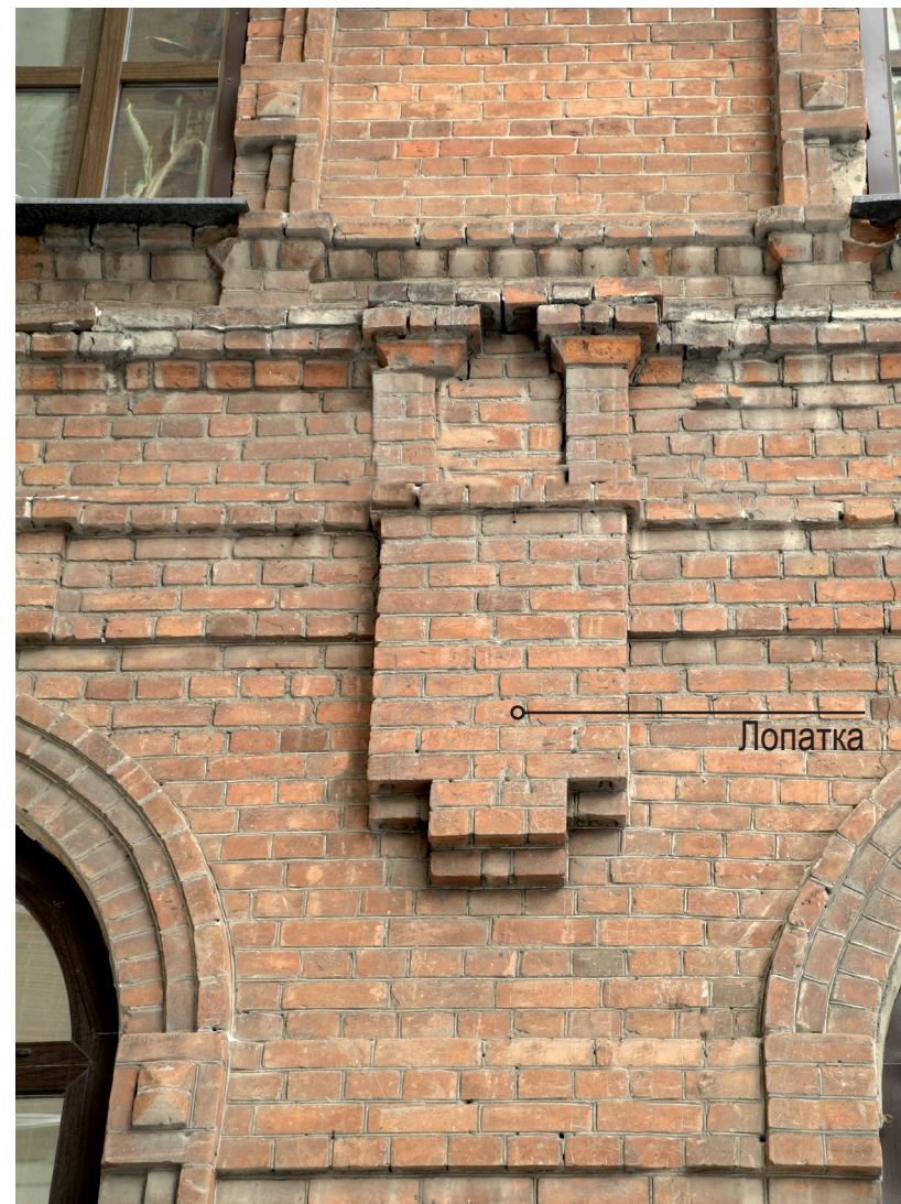
Фрагмент южного фасада
